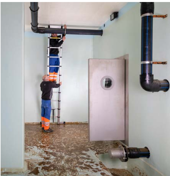
Une équipe s'affaire à l'entretien des infrastructures de traitement des eaux.
