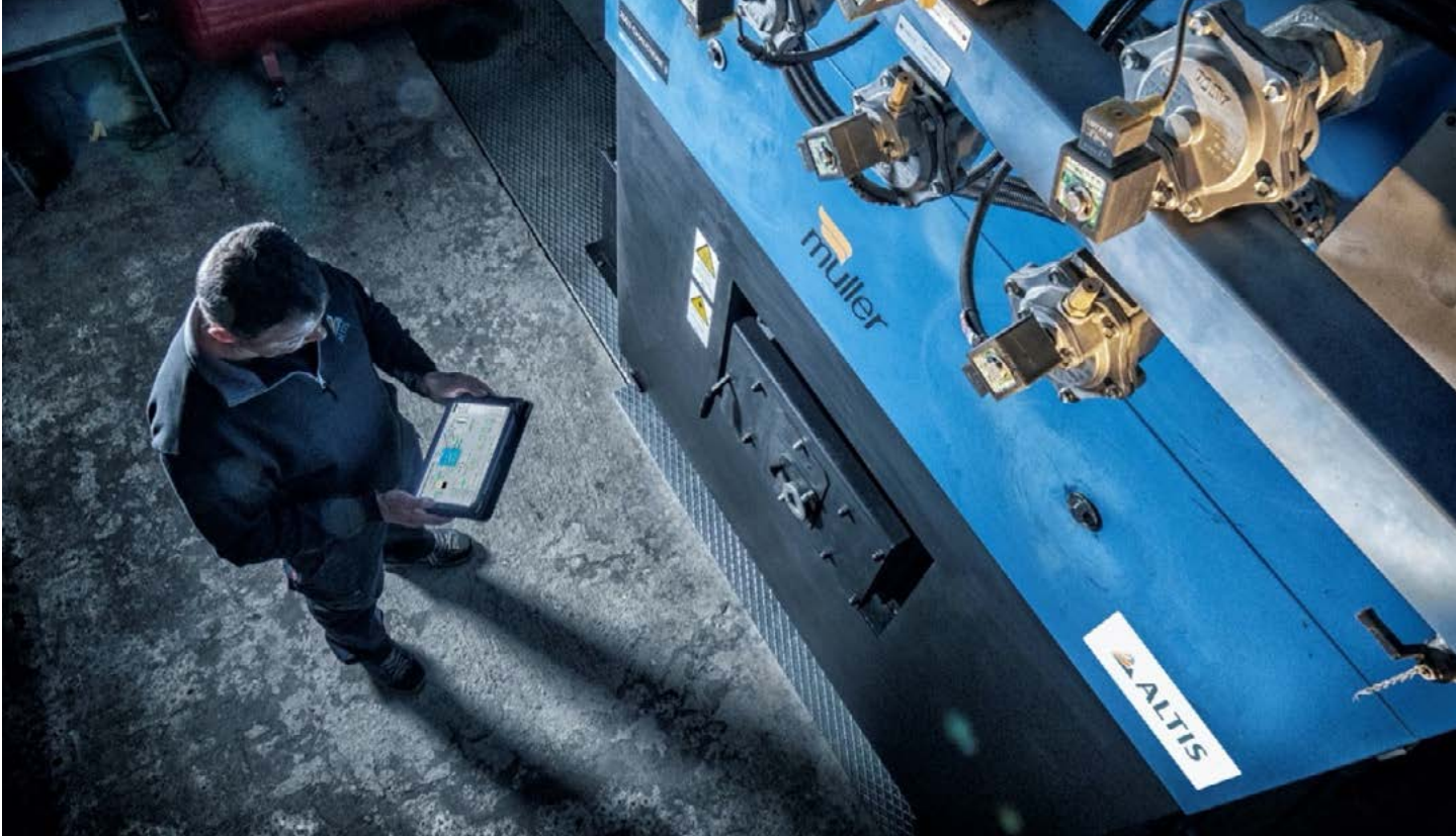
Chauffage à distance, pompes à chaleur ou intégrations mixtes, ALTIS assure aujourd'hui le chauffage de plus d'une centaine de bâtiments en Entremont.
