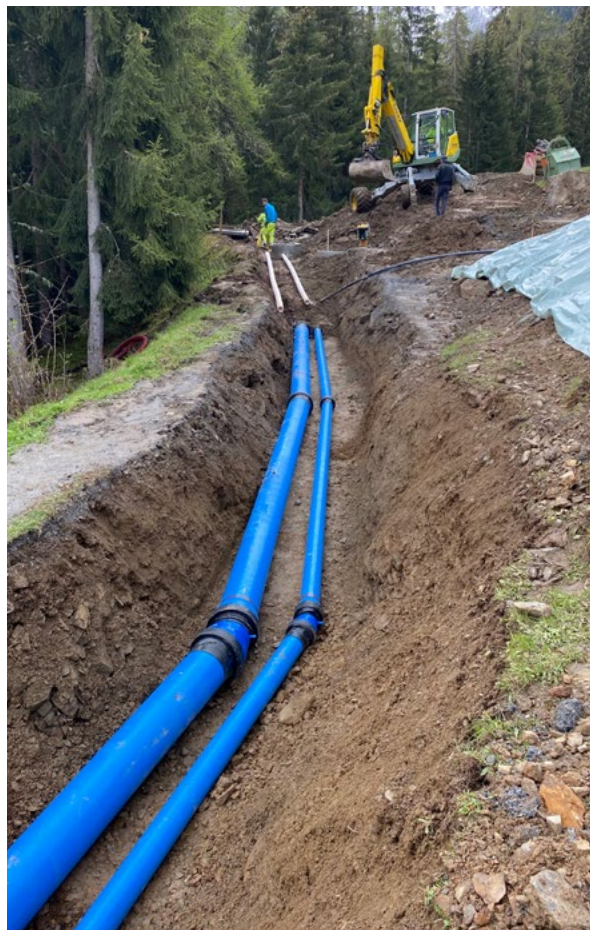
Installation de la conduite de turbinage entre Les Changemaux et La Montoz.
