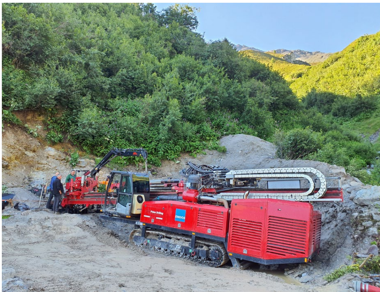
Travaux de forage pour récupérer les eaux des torrents situés dans le secteur du plan d'Arolle.
